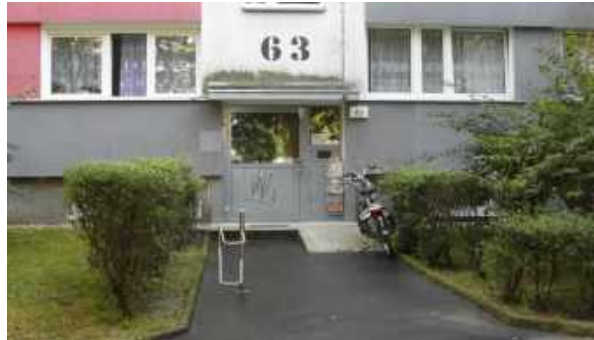
Rys. 115. Pochylnia przed wejściem do budynku (zdj. autor)
