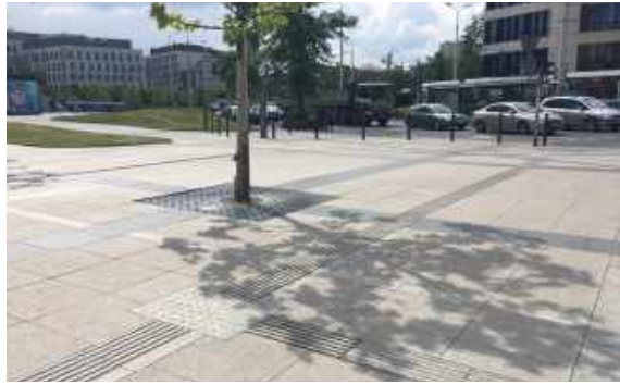
Rys. 45. System FON - będący kombinacją faktur wyczuwalnych pod stopą lub końcówką laski, faktury kierunkowe prowadzące do przejść dla pieszych oraz faktura uwagi (informacji) na rozwidleniu faktur kierunkowych. Plac przez dworcem głównym PKP, Wrocław, realizacja 2012 rok (zdj. autor).
