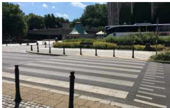
Rys. 47. Fakturowe i kolorystyczne pole uwagi przed przejściem dla pieszych, podwyższenie jezdni do wysokości przejścia dla pieszych – na wysokość chodnika. Słupki przed przejściem stanowiące przeszkody dla pieszych. Ulica Jana Ewangelisty Purkyniego, Wrocław, realizacja 2014 rok (zdj. autor)
