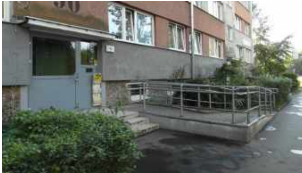
Rys. 114. Rampa przed wejściem do budynku (zdj. autor)
