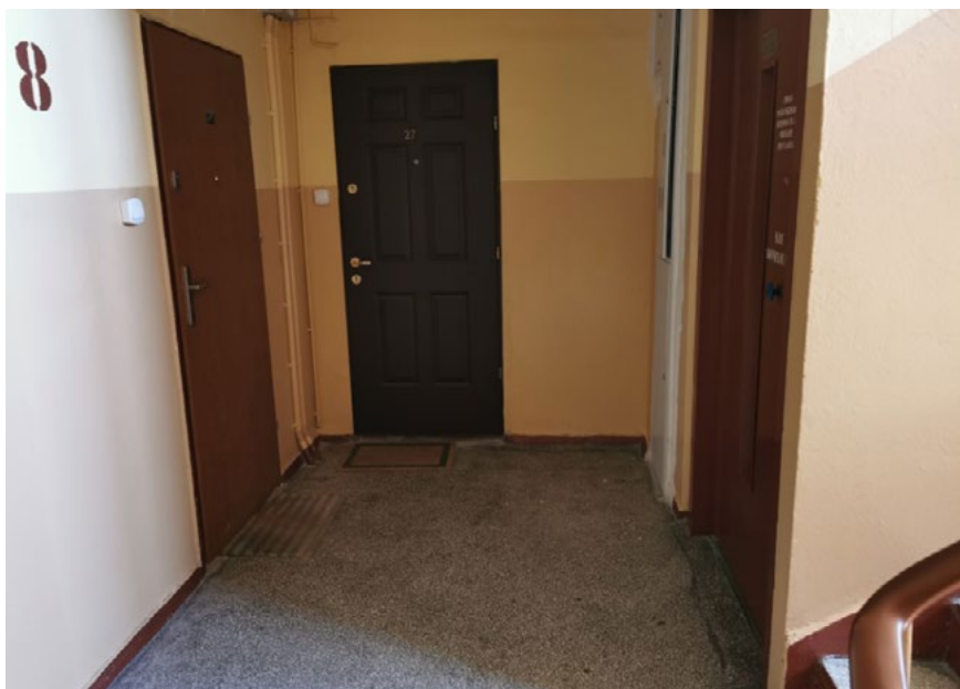
Fot. 27. Popowice – klatka schodowa jednego z budynków mieszkalnych
