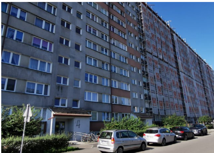
Fot. 32. Popowice – trwająca modernizacja jednego z budynków mieszkaniowych
