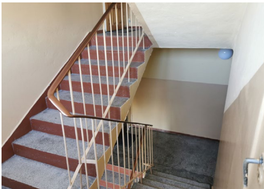
Fot. 26. Popowice – klatka schodowa jednego z budynków mieszkalnych
