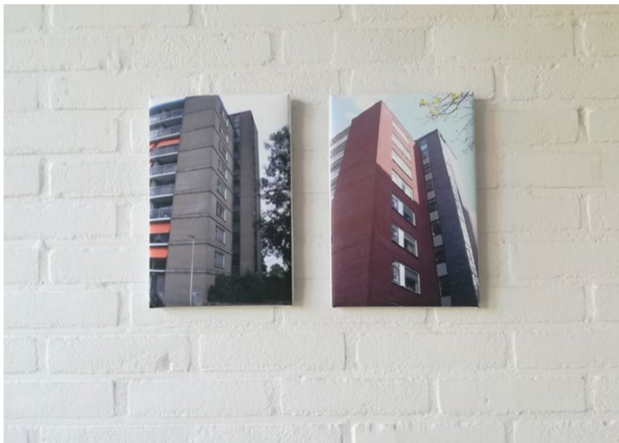
Fot. 15. Budynek przed i po modernizacji
