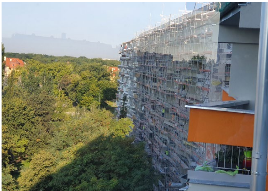
Fot. 31. Popowice – trwająca termomodernizacja jednego z budynków mieszkaniowych
